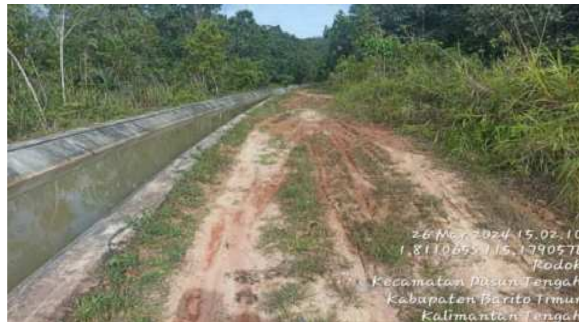
PHOTO KONDISI SAAT INI
